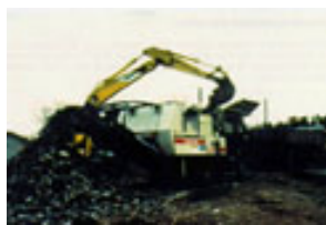
アスコンリサイクル
